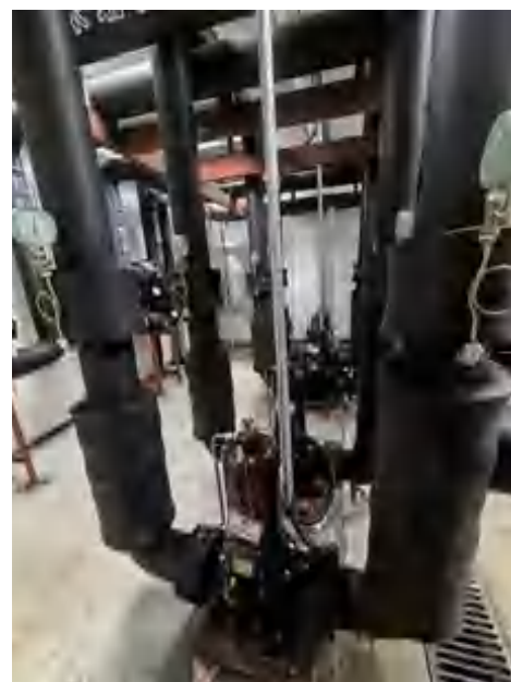
机房更换水泵、安装减震垫
